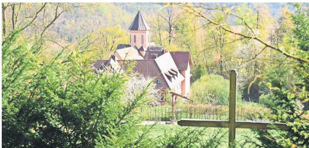
Die Klosterkirche ist auch aus der Ferne zu erkennen. Die Außenarbeiten neigen sich dem Ende zu.
