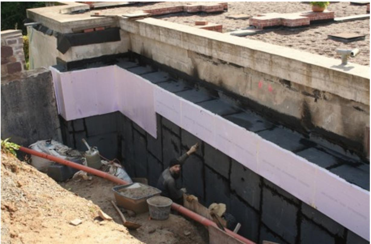
ab und klebte alles zur Drucksicherung zusätzlich mit einer (diesmal mäusefraßsicheren) Perimeterschicht ab. 30 Tonnen Kies wurden von Hand in die Drainagegräben verbracht, und am Marienturm das Gelände wieder hergestellt. Dabei halfen immer wieder unsere Brüder Odulf, Silas, Wittekind, Godehard und Alexander.
