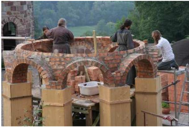
dient, auf deren anderem Ende dann Stein für Stein im rechten Winkel angelegt und vermauert wird. So entsteht eine präzise Halbfugel. In dieser Technik mauerten wir eine Innenschale aus Gitterziegeln und darüber, der stimmigeren
